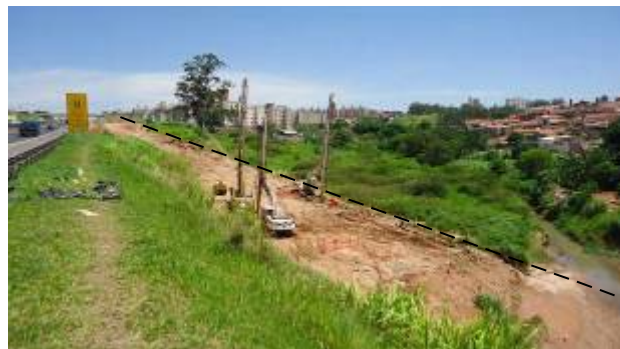
Figura 5. O canteiro de obras do CPR, observando a linha pontilhada, onde passa o gasoduto. A direita o rio que também teve tratamento CPR.
