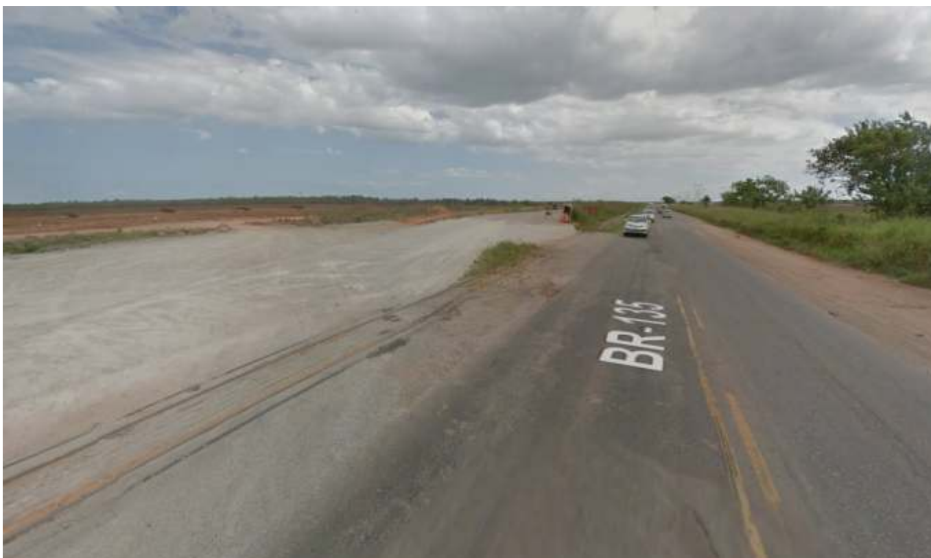
Nesta foto observa-se em primeiro plano a antiga BR-135 e ao lado antiga Transnordestina. Mais a esquerda verifica-se o solo pós CPR Grouting, já recebendo os preparativos para o asfalto. Mais a esquerda está reservado a construção da nova ferrovia Transnordestina, que ficará alinhada com a ferrovia Carajás.
