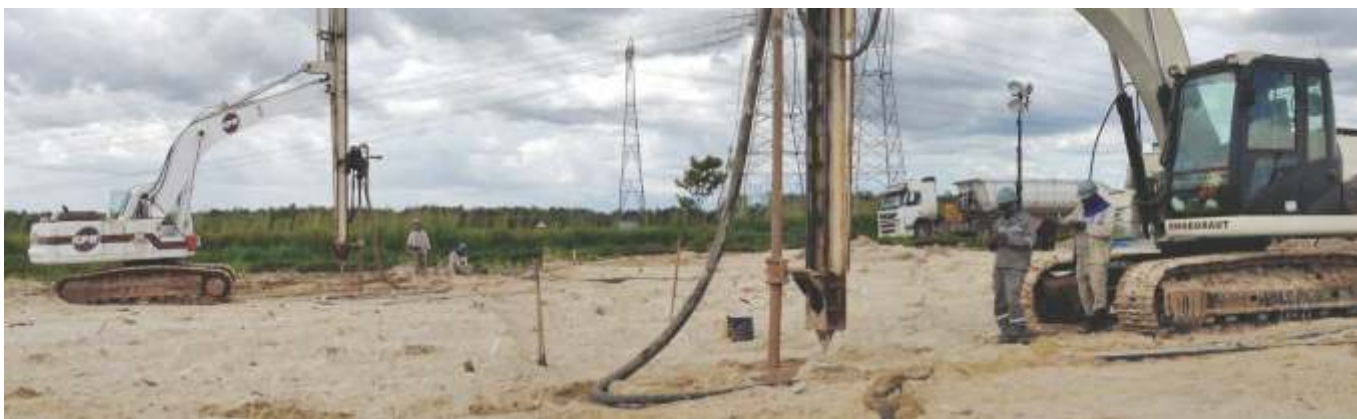
Os serviços de formação das verticais com bulbos de compressão e adensamento, após a cravação dos geodrenos. Ao fundo a antiga BR-135.
