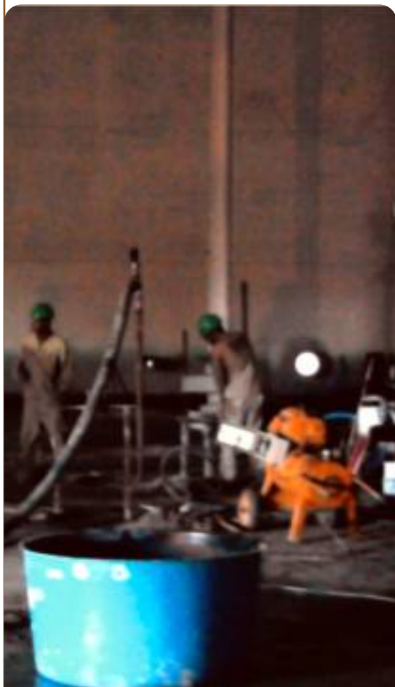
Tanque para armazenagem e movimentação de produtos derivados de petróleo
