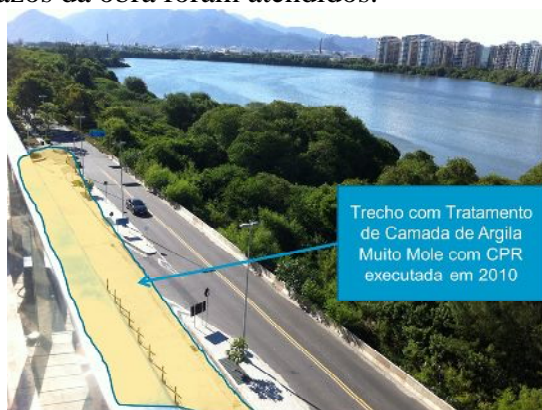
Figura 2. Área de tratamento de solo mole em trecho da Via de Acesso (Geoinfra, 2010)
